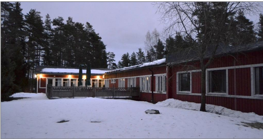
Kuva 24. Hotellin pääjulkisivua. Kuvan oikeassa reunassa toinen rakennusosa. Alkuperäisen rakennusosan ja laajennuksen liitoskohta näkyy julkisivussa selkeästi.
