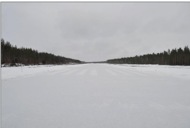
Kuva 3. Kuva pitkän kiitotien lounaispuolelta koilliseen.
