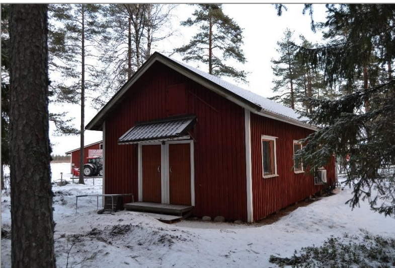
Kuva 14. Rakennuksen länsipääty ja eteläsivua. Rakennuksen takaa vasemmalla näkyy lentokonehalli (rakennus nro 6).
