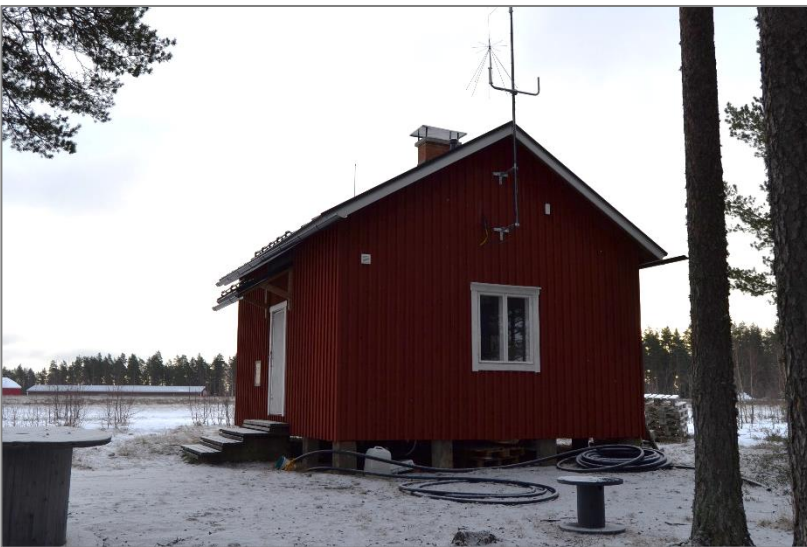
Kuva 19. Lennonjohtorakennus kuvattuna lännestä. Taustalla näkyy kiitorata-alue ja kentän toisella laidalla sijaitsevia lentokonehalleja.
