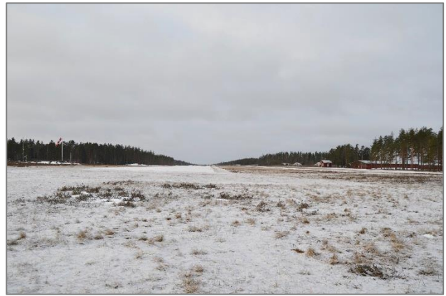
Kuva 4. Kuva kiitotiealueen koillispuolelta lounaaseen. Oikeassa laidassa näkyy vanha lennonjohtorakennus.
