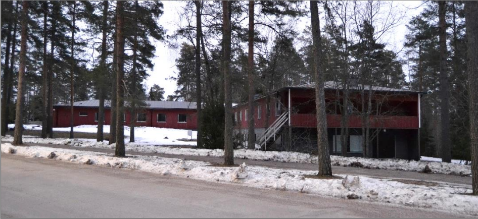
Kuva 30. Hotellirakennus kuvattuna Lentokentäntieltä. Vasemmalla toinen rakennusosa, oikealla kolmannen rakennusosan pääty. Molemmat laajennusosat ovat aumakattoisia, katteena on saumapelti.
